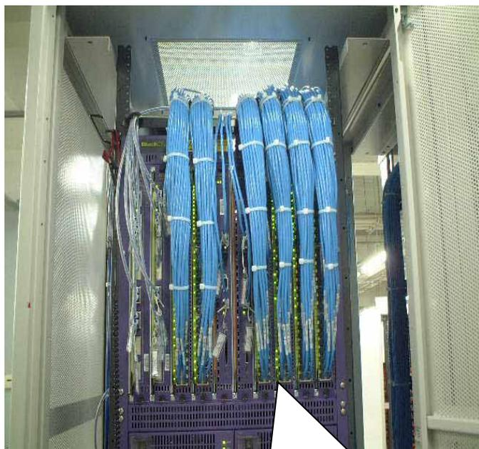
ケーブルが大量に布線されており、故障カードの交換に時間がかかる
