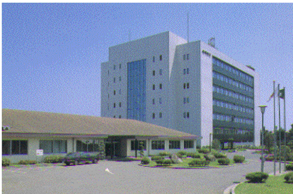
古河電気工業 (株) 平塚事業所 ネットワークセンター
