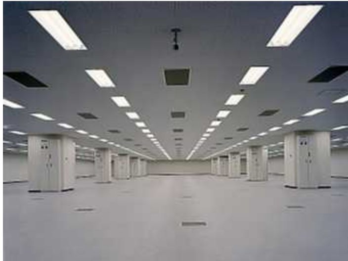
天井のあるサーバールーム
