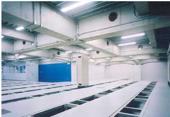
天井のない直天井のサーバールーム
