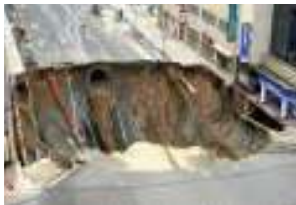
平成28年 博多駅前陥没事故 (2016年11月)
