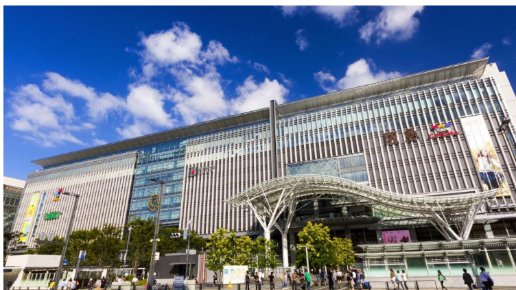
写真提供：福岡市
