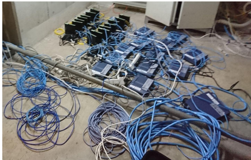
2019年の幕張メッセ地下ピットの様子
