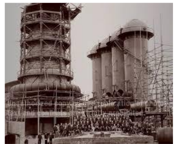
鉄鋼 八幡製鉄所
