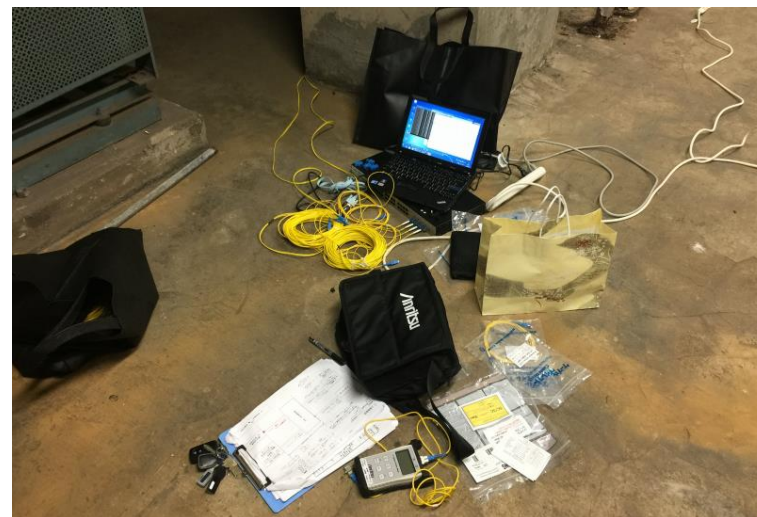
素人 ファイバー 接続工事
