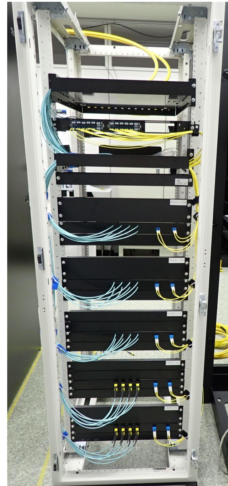
模擬GPUサーバラック
