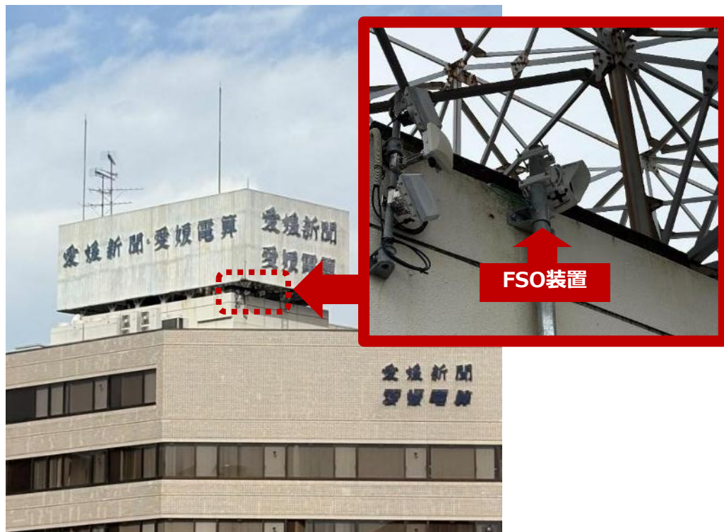
愛媛CATV本社ビル屋上
